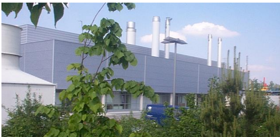
Prüfstandsgebäude des Lehrstuhls mit Gasturbinen- und Komponenten-Prüfständen
