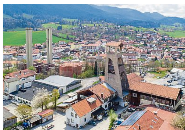
Viele Eigentümer: Rund um den Förderturm will die Technische Universität München aufzeigen, welche Entwicklungsmöglichkeiten es in der Nutzung der Gebäude gibt – obwohl sie nicht in einer Hand liegen. FOTO: TP
